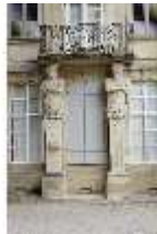
BayNS.I, Balkontrakt mit spätbarocken Hermen, DI022773, BSV
