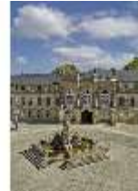
BayNS.I, Ansicht der Fassade mit Vorplatz u. Brunnen, DI023724, BSV
