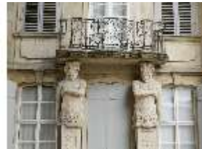
BayNS.I, Balkontrakt mit spätbarocken Hermen, DI022774, BSV
