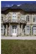
BayNS.I, Badetrakt, Fassade zur Gartenseite, DI022782, BSV
