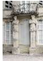
BayNS.I, Balkontrakt mit spätbarocken Hermen, DI022775, BSV
