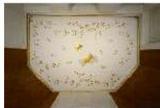
BayNS.II, Kommunikation, Ruhezimmer (R.30), Decke, DE002445, BSV
