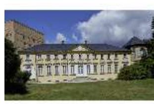
BayNS.I, Italienisches Schlösschen, Fassade, Gartenseite, DI022781, BSV
