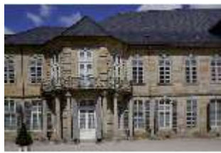
BayNS.I, Badetrakt, Fassade zur Gartenseite, DI022783, BSV
