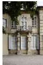
BayNS.I, Balkontrakt mit spätbarocken Hermen, DI022770, BSV
