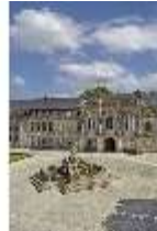
BayNS.I, Ansicht der Fassade mit Vorplatz u. Brunnen, DI023723, BSV
