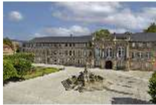
BayNS.I, Ansicht der Fassade mit Vorplatz u. Brunnen, DI023722, BSV
