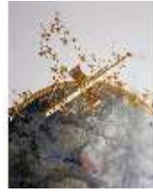
BayNS.II, Deckengem. u. - stuck, Det.R.1.14, DE001804, BSV-
