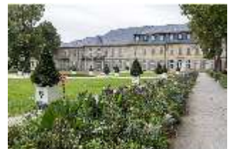
BayNS.V, Neues Schloss, Gartenfassade, DI028317, BSV-
