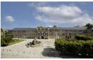
BayNS.I, Ansicht der Fassade mit Vorplatz u. Brunnen, DI023721, BSV
