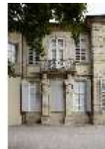
BayNS.I, Balkontrakt mit spätbarocken Hermen, DI022771, BSV
