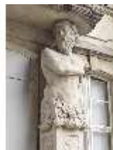
BayNS.I, Balkontrakt mit spätbarocken Hermen, DI022778, BSV
