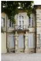
BayNS.I, Balkontrakt mit spätbarocken Hermen, DI022772, BSV
